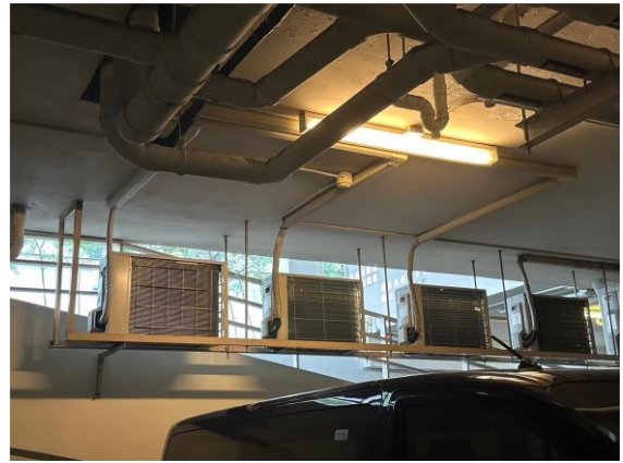
รูปที่ 2-21 ตำแหน่งของคอมเพรสเซอร์แอร์
